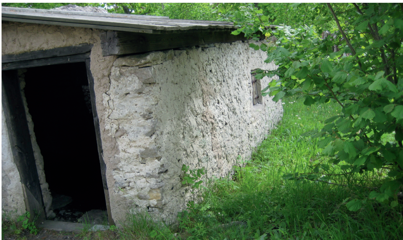
Abbildung 1: Gotlandhaus, Haus auf Gotland aus Kalkstein mit Lehm „verputzt“ (Freilichtmuseum Bunge)
